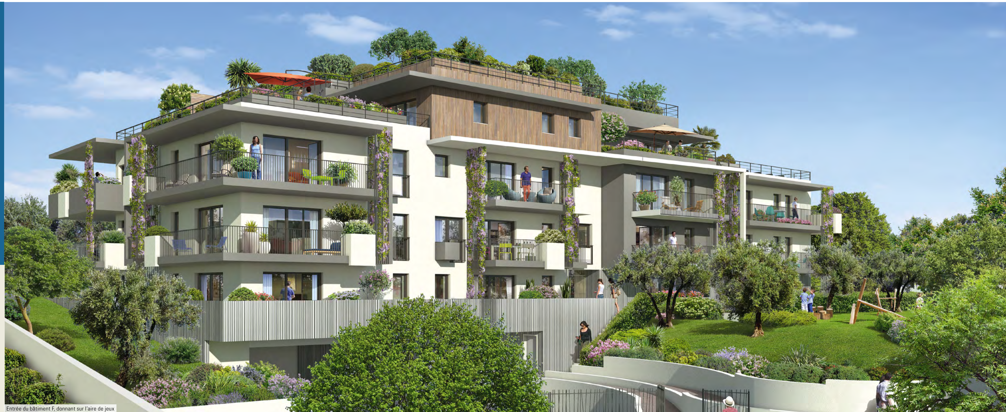
Entrée du bâtiment F, donnant sur l'aire de jeux
