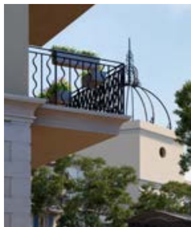
Balcons et éléments de serrurerie
